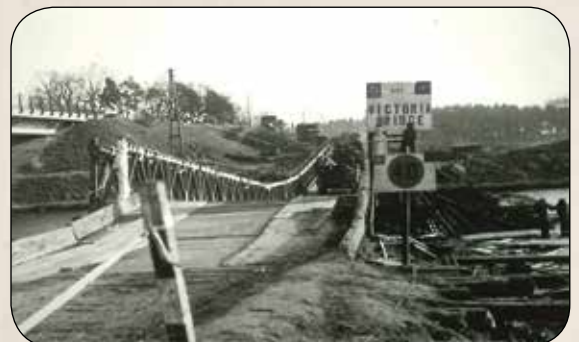
De Victoriabridge is klaar, de tanks kunnen eroverheen rijden
