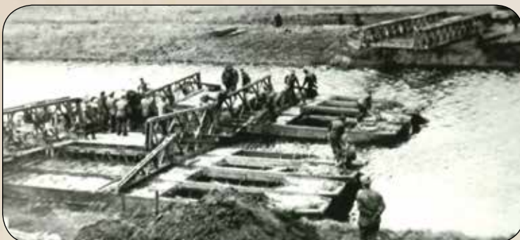
De Victoriabridge in aanbouw
