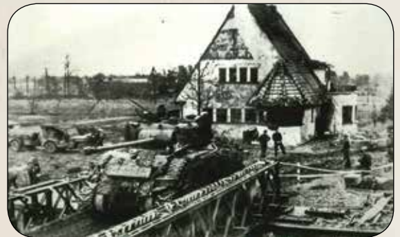
Een Sherman tank rijdt over de sluis
